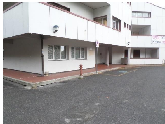
Figura 4.1 - Particolare della porzione di involucro
