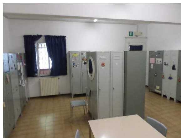
Figura 4.5 - Particolare radiatori a parete
