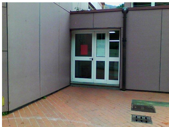
Figura 4.4 –Rilievo termografico dei serramenti
