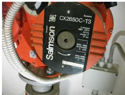
Figura 8.4– Particolare delle pompe di circolazione
