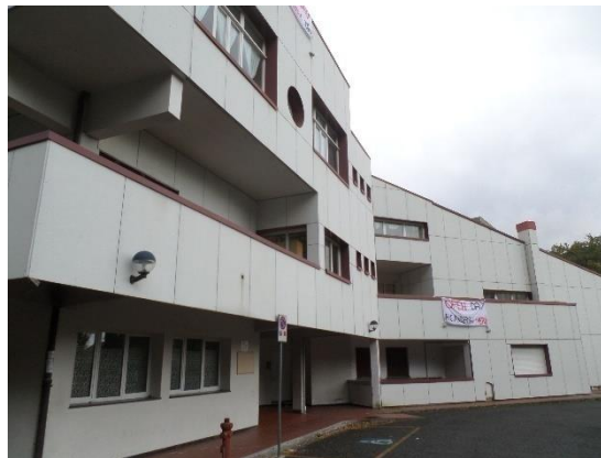
Figura 1.1 - Vista della facciata esposta a Nord
