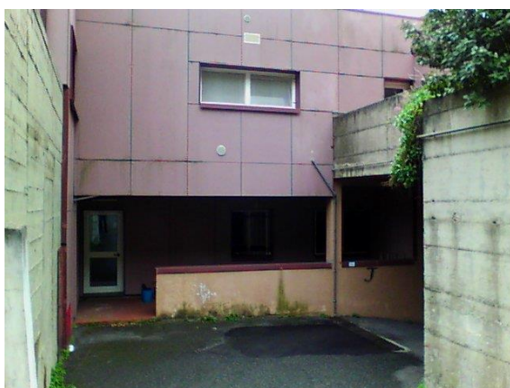
Figura 4.2 –Rilievo termografico della parete ovest
