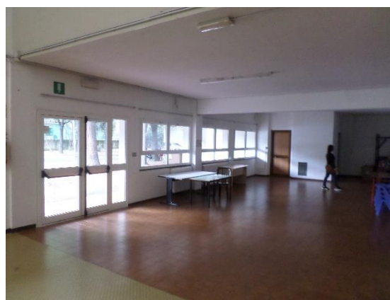
Figura 8.6 - Particolare dei corpi illuminanti attualmente installati
