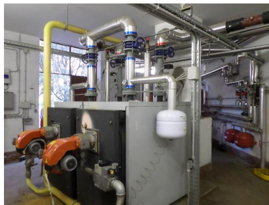
Figura 8.1 – Particolare della caldaia attuale
